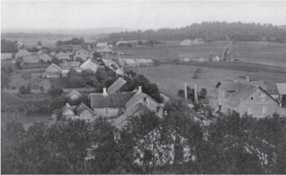
Vaade Rakke asula lõunapoolsele osale kirdest. Pildistatud Kadaka tuuleturbiini tornist 1925. aasta paiku
