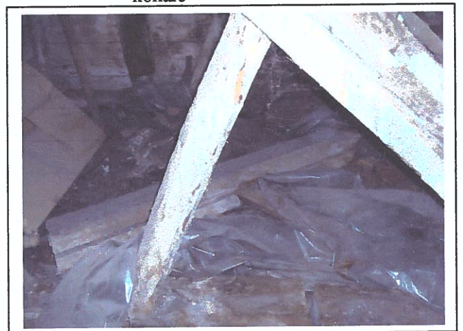
Foto 36 III eh jrk hoone ehitamisel demonteeriti 1 korruse sein. Sarikoormus viidi kaldtugedega uue seina kohale
