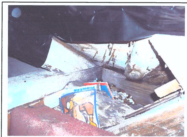
Foto 28 Detail fotost 27 Vaade algupärase karniisi tarindusele – näha on seinast üleulatuv horisontaaltala ots, millele toetub sarikas. Nende külge on naelutatud karniisilaud
