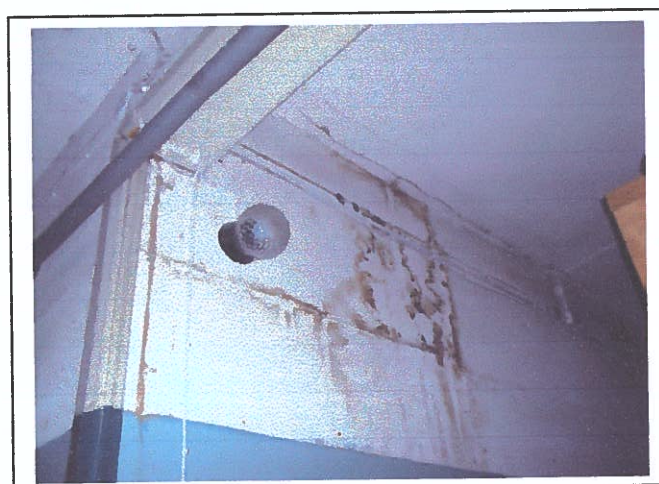
Foto 38, 39 Vaade I eh jrk hoone esimesel korrusel olevas ruumis – läbijooksude kohal on vahesein koos vahelaega alla vajunud
