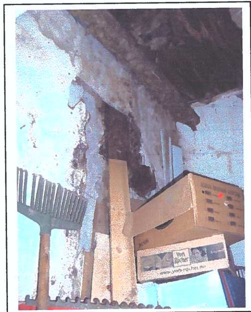
Foto 38, 39 Vaade I eh jrk hoone esimesel korrusel olevas ruumis – läbijooksude kohal on vahesein koos vahelaega alla vajunud
