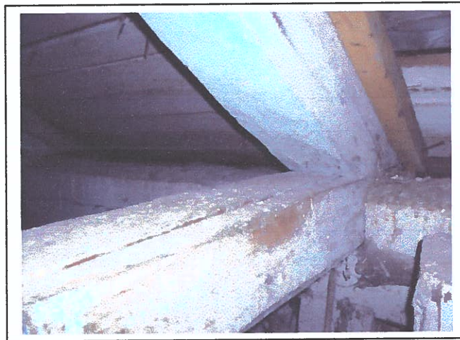
Foto 33 Vaade III eh jrk hoone lõunapoolse müürlati toetusele ja karniisi moodustavale horisontaalsele sõrestikule.
