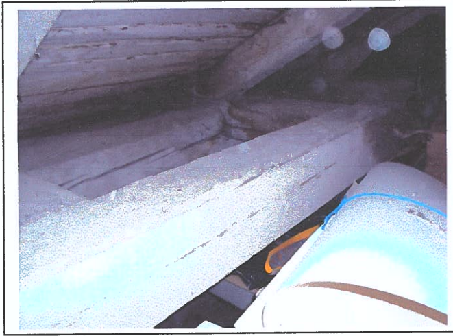
Foto 33 Vaade III eh jrk hoone lõunapoolse müürlati toetusele ja karniisi moodustavale horisontaalsele sõrestikule.
