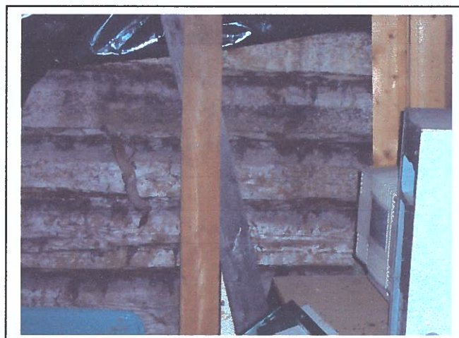
Foto 24 Vaade II ja III eh jrk hoonete vahelisele palkseinale. Alumised 4 palgirida on II eh jrk hoone omad
