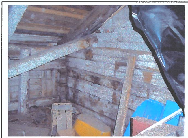
Foto 21 Vaade II ja III eh jrk liitekohale, hoone põhjafassaadi idanurgale II ja III eh jrk vahelises seinas nähtavad 4 alumist palki on II eh jrk sein, 2 ülemist palki on paigaldatud III-s eh jrk-as
