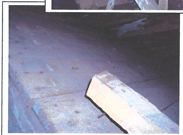
Foto 17 Detail fotost 16 I eh.jrk plekk-katuse aluslaudis on pööningul nähtav ning on heas ehitus-tehnilises seisukorras
