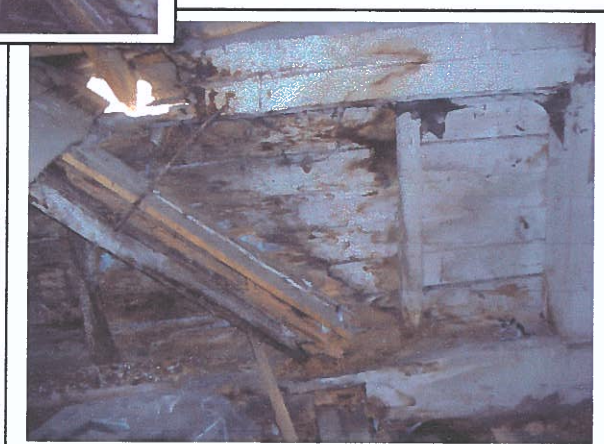
Foto 18 Detail fotost 16 I ja III eh.jrk katuste neelukoht on kõdunenud, algupäraseid katuste sarikaotsad on pehkinud. Näha III eh.jrk hoone põhjapoolne laudisest välissein
