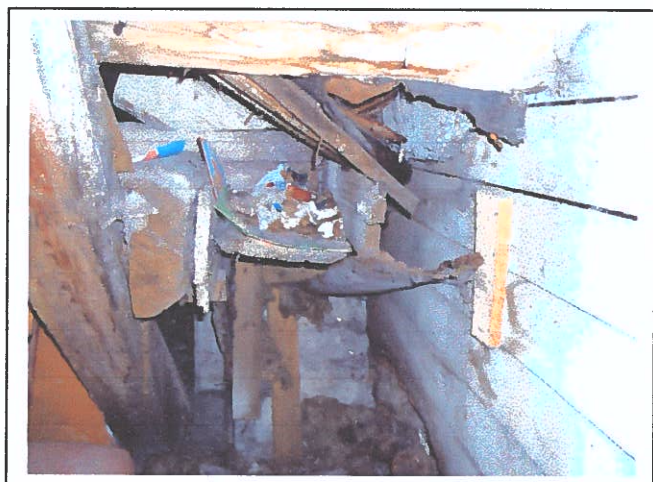
Foto 29 Näha on I eh jrk sarikas koos säilinud karniisiga. Üleval on näha lagunenu neelu põhi
