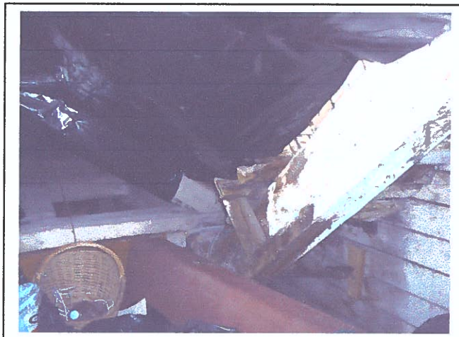
Foto 27 Vaade I eh jrk hoone idaseina väljaehituse ja III eh jrk hoone lõunaseina liitumiskohale
